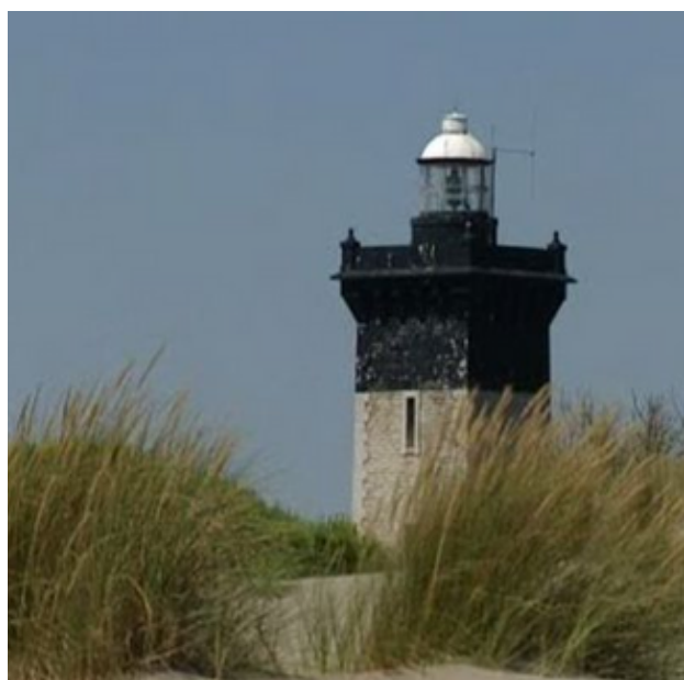
Rénovation du phare de l'Espiguette (30)
