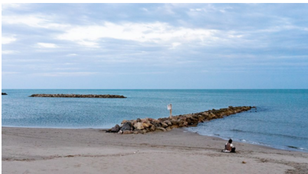
Transformation de l'épi en brise-lames à Vias (34)
